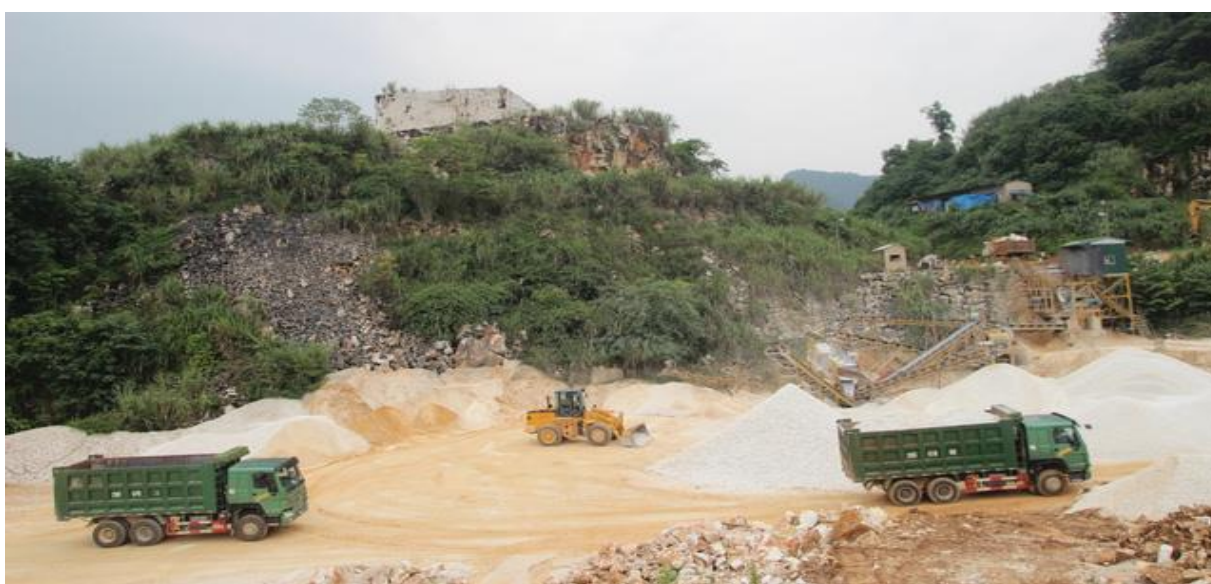
Ảnh: Mỏ đá Thung Hung tại xã Châu Tiến, huyện Quỳnh Hợp, tỉnh Nghệ An.
